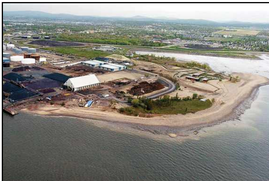
Le projet implique d'allonger de 600 mètres les quais du Port de Québec à la baie de Beauport. Photothèque Le Soleil, Erick Labbé
